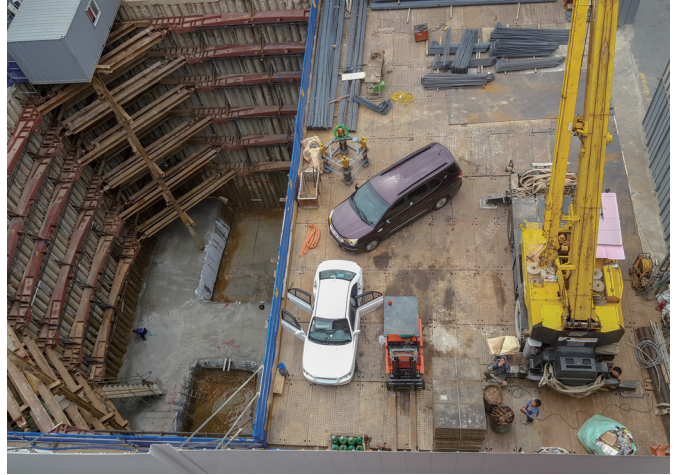
천안시 안서동 근린생활시설 67.5x22.0x6.2m (주)HS건설
